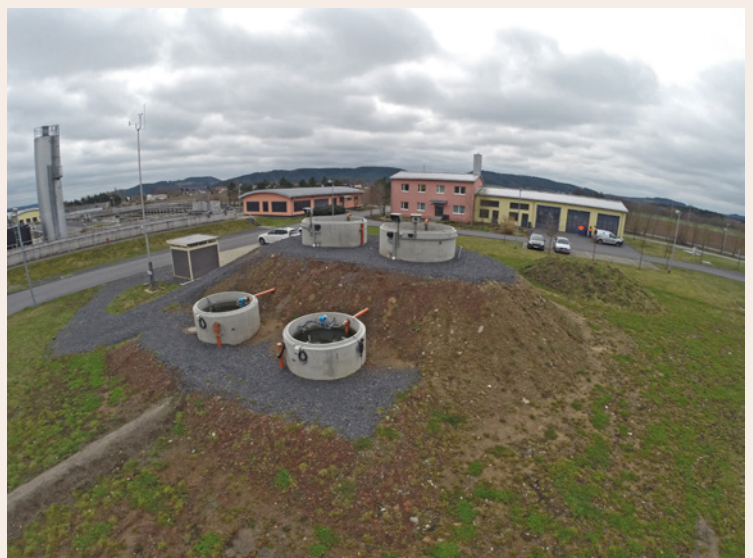
Bild 5: Versuchskläranlage auf der Kläranlage Sonneberg-Heubisch zum vergleichenden Betrieb der biologischen Reinigungsstufe mit Elektrolysesauerstoff und Umgebungsluft (Bildquelle: Andre Funke, Wasserwerke Sonneberg)
